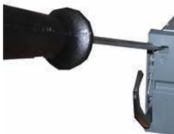
Рисунок 3.1 – Демонтаж выпрямителя FLATPAK2 48-60/2000 HE. Отщелкивание фиксаторов.
